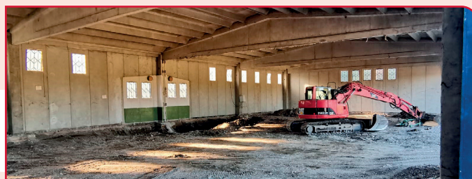
Radovi na podatkovnom centru HR-ZOO ZG2 (lokacija kampus Borongaj)
